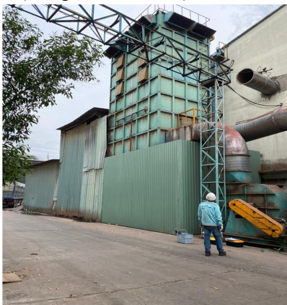
HTXLKT tại công đoạn chà nhám (xưởng sản xuất ván PB)
